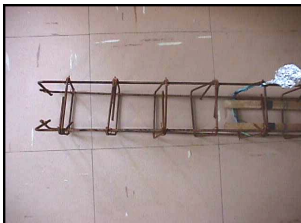
Figura 1 – Detalhe da armadura da viga 1
