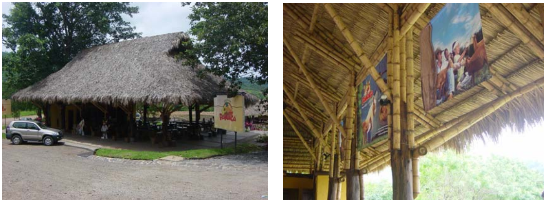
Figuras nº 26 e 27: Aspecto geral e vista interna do restaurante do Parque Natural Agropecuário da Costa Rica - PANACA. Fonte: Marquez, 2007
