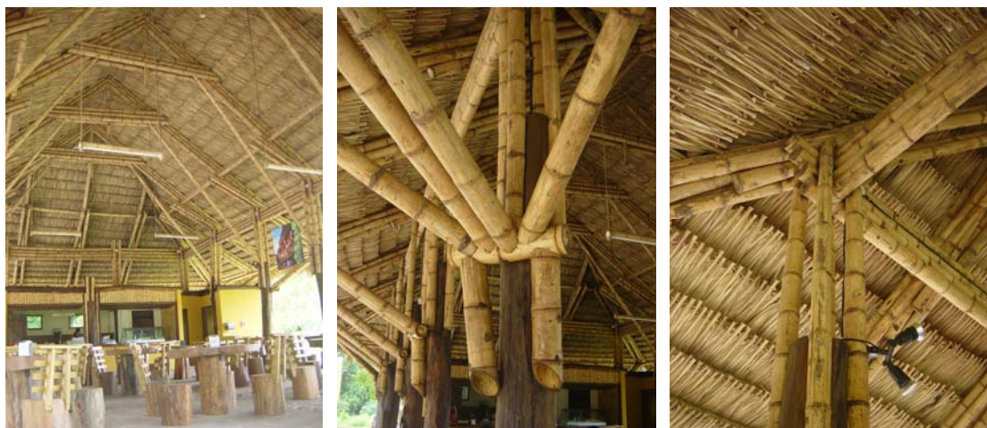
Figuras nº 28 e 29 e 30: Vista interna da cobertura, detalhes do encontro entre peças estruturais.
