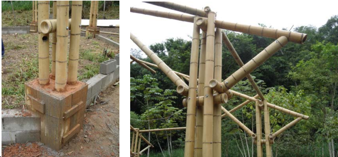
Figura nº 24: Encontro dos pilares com a fundação na Sede da IBIOSFERA. Fonte: Marquez, 2007
