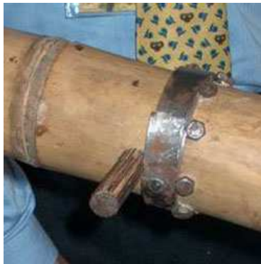
Fig.23- unión con tornillos – D.Trujillo
