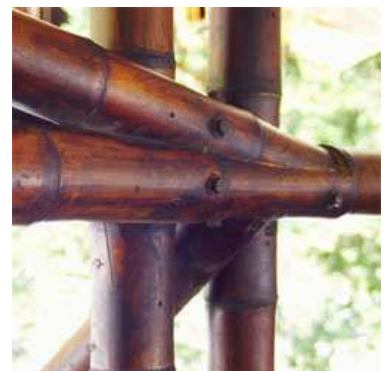
Fig. 15 – mortero y pasador – J.Stamm
