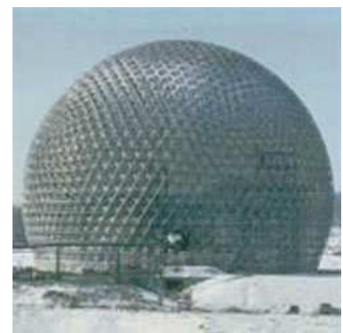
Fig.33-cúpula geodésica de acero Montreal (Canada)
