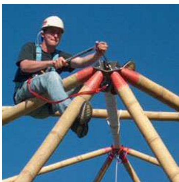
Fig. 20 - unión con platina - C.Tönges
