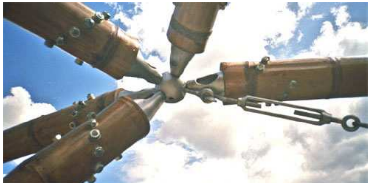
Fig.27- prototipo de la unión – Pabellon "Mariposa" T.Oberman + R.Laude
