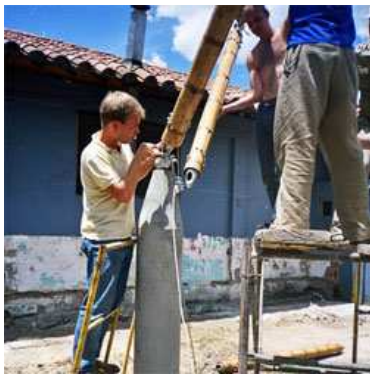
Fig.50-articulación con la columna
