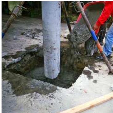
Fig.45 - montaje de las columnas
