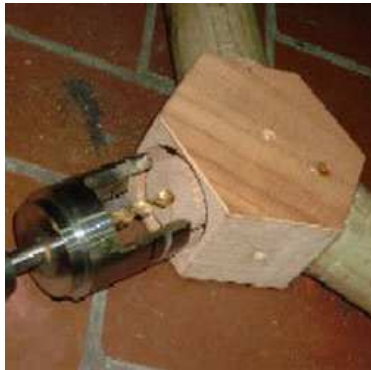
Fig.16 - unión con madera - BAMBUITEC
