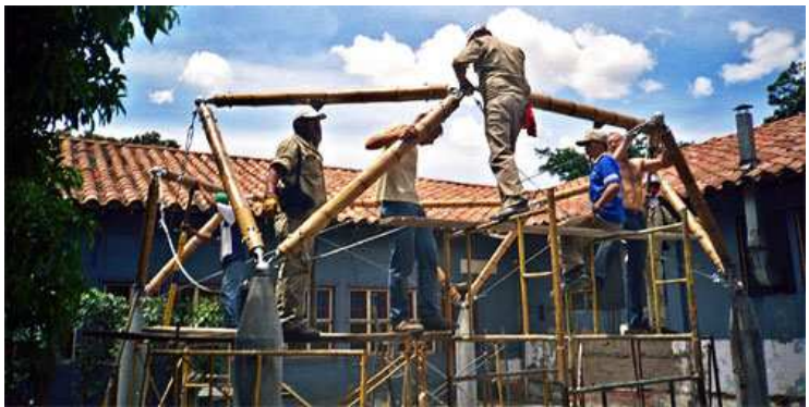
Fig.51- cierre del octágono
