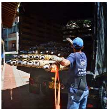
Fig.42 - llegada de la guadua prefabricada.
