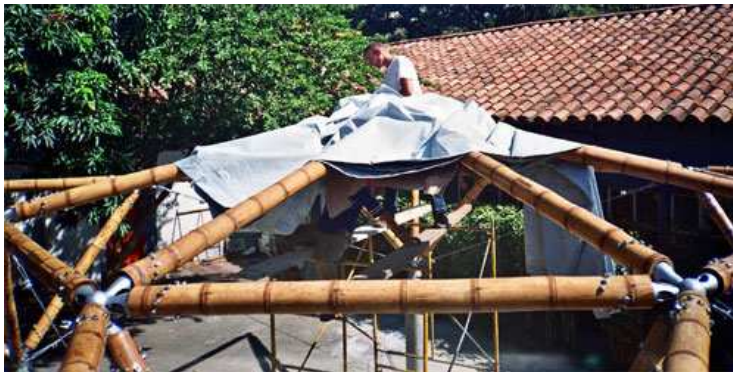
Fig.56 – poner la membrana sobre la estructura
