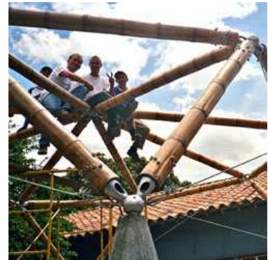
Fig.53- prueba de carga
