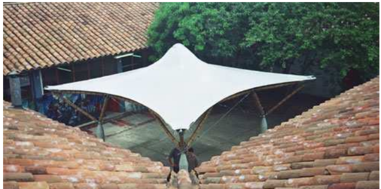
Fig.59 – membrana tensionada vista desde arriba
