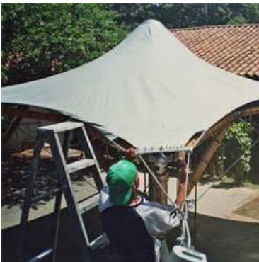
Fig.58 – pretension en los bordes
