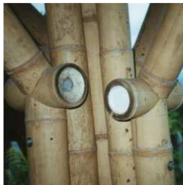
Fig. 14 – unión con “boca de pescado”
