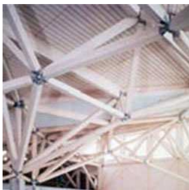
Fig.31-malla espacial de madera Fallanden (Suiza)
