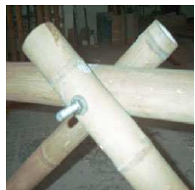
Fig.21- unión con tornillos - Gutierrez
