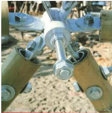
Fig.22- unión con tornillos – S.Yoh
