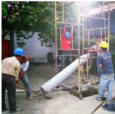
Fig.44 - montaje de las columnas
