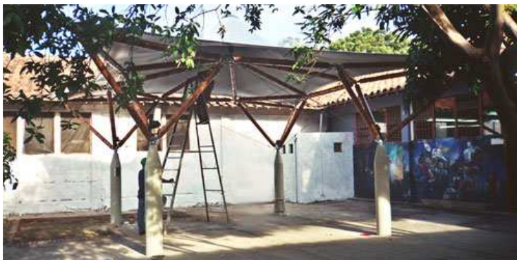
Fig.60 – pabellón completa con membrana
