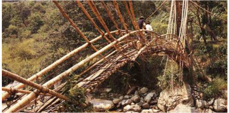
Fig. 7 – puente tradicional de guadua en colombia
