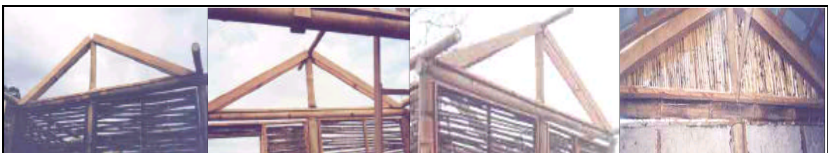
Figura 5. Sequência construtiva da estrutura da cobertura.
