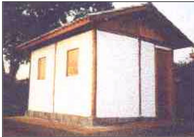
Figura 9. Vista final da construção.
