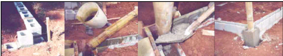
Figura 3. Seqüência construtiva da fixação do pilar na fundação.
