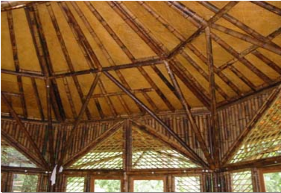
Figura 28: Detalhe da estrutura do telhado, vigas, mão francesa e vedação.
