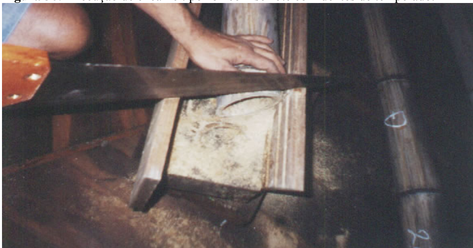
Figura 36: Execução de encaixe tipo 45° com serrote com dentes de temperado.
