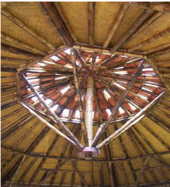
Figura 29: Ponto central de sustentação do telhado (mãos francesas).
