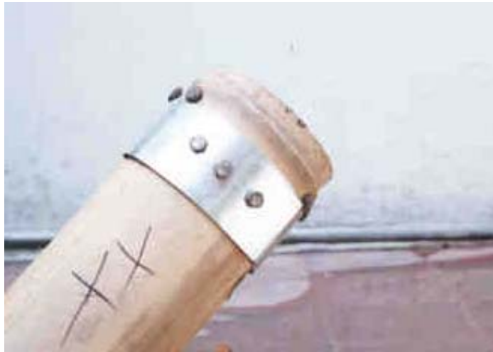
FOTO 14 DETALLE ANILLO DE ACERO
